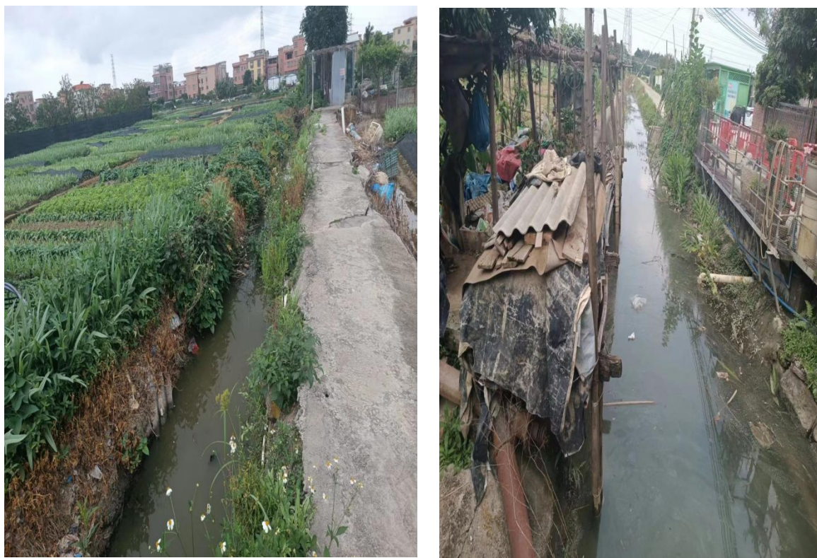
图 2-5 项目区现状渠道照片
