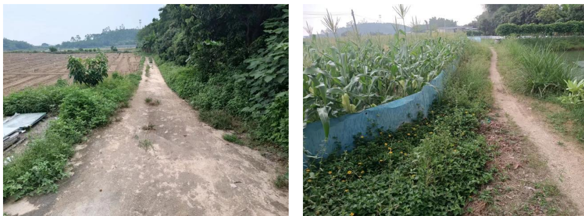
图 2-3 项目区现状田间道路照片
