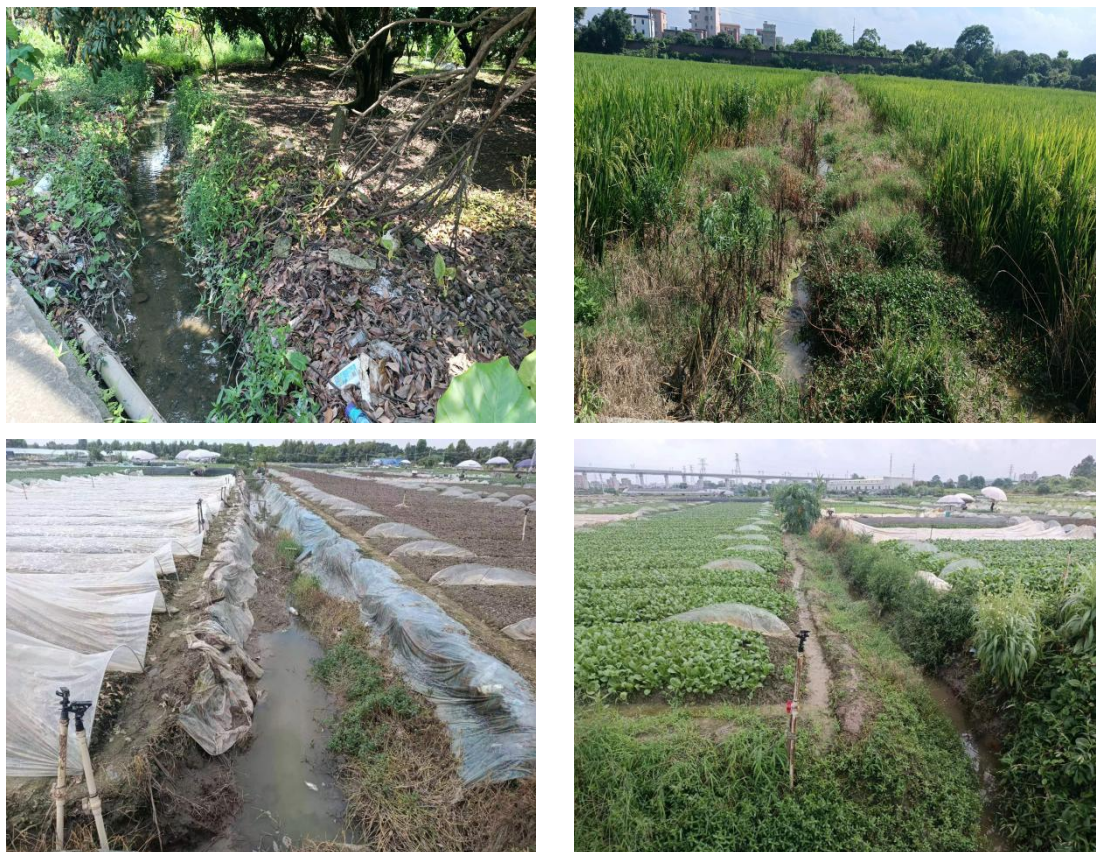
图 2-2 项目区现状渠道照片
