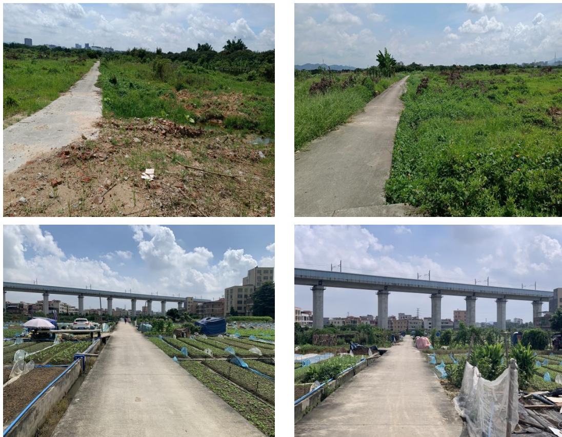
图 2-1 项目区现状田间道路照片
