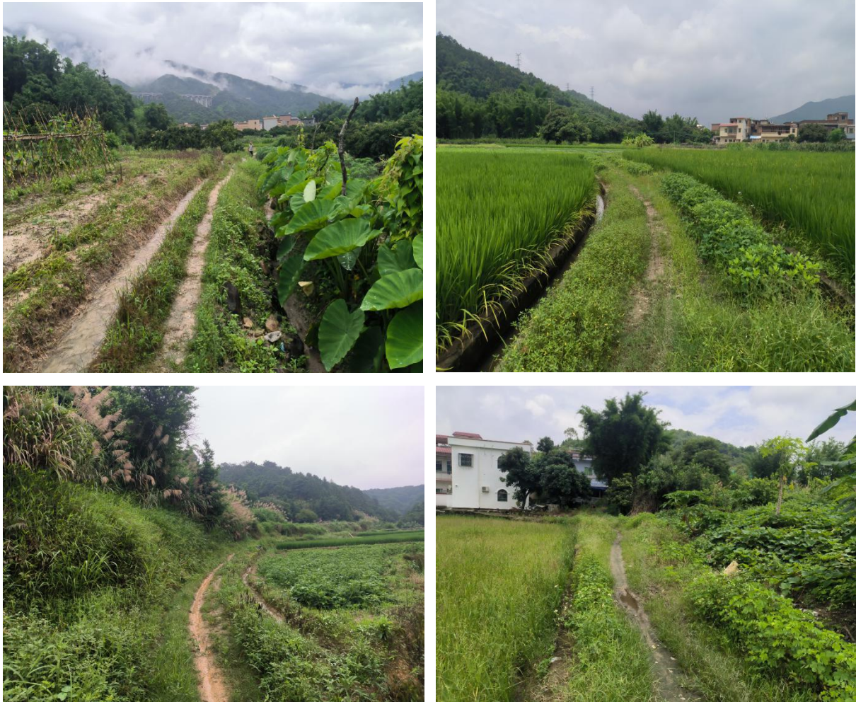
图 3-1 现状未完成硬底化建设道路
