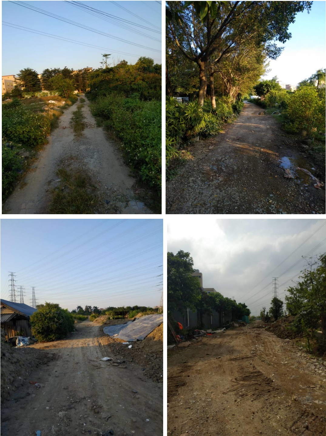
图 3-1 项目区路面现状
